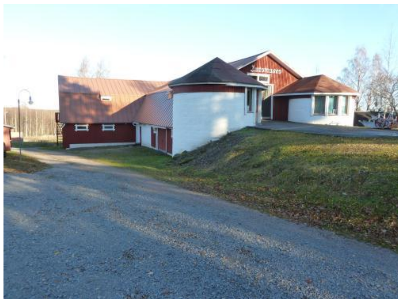
Entinen Osuusliike Imatran navettarakennus, nykyinen automuseo.
